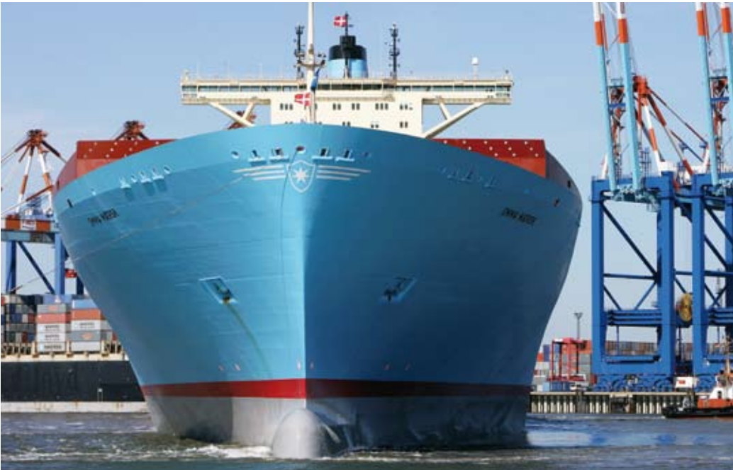
Containerriesen wie die »Emma Mærsk« brauchen immer tiefere Fahrrinnen, um ihre Bestimmungshäfen (im Bild Bremerhaven) anlaufen zu können.
